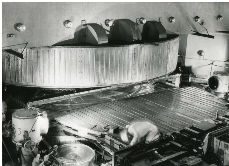
Рис. 5.9. Ремонтные работы на дуанте, выдвинутом из камеры синхроциклотрона ПИЯФ
