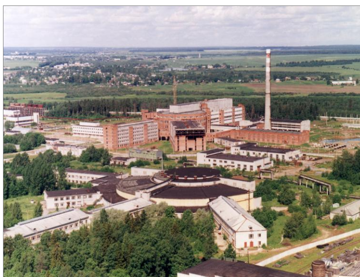
Рис. 2.1. Общий вид комплекса зданий синхроциклотрона ПИЯФ
