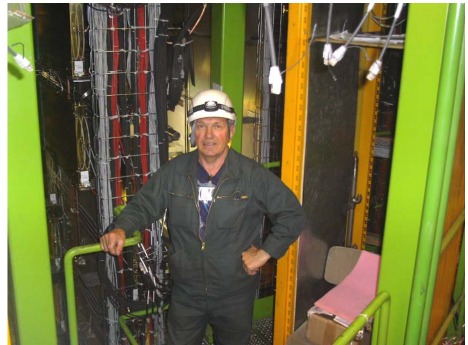
Монтаж кабельных коммуникаций детектора LHCb
