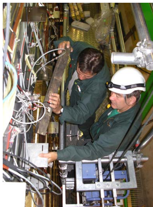
Рабочий момент монтажа камер
