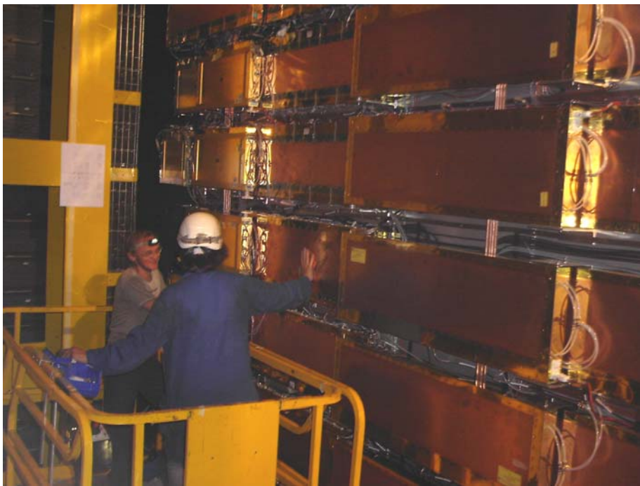
Монтаж камеры на детекторе LHCb
