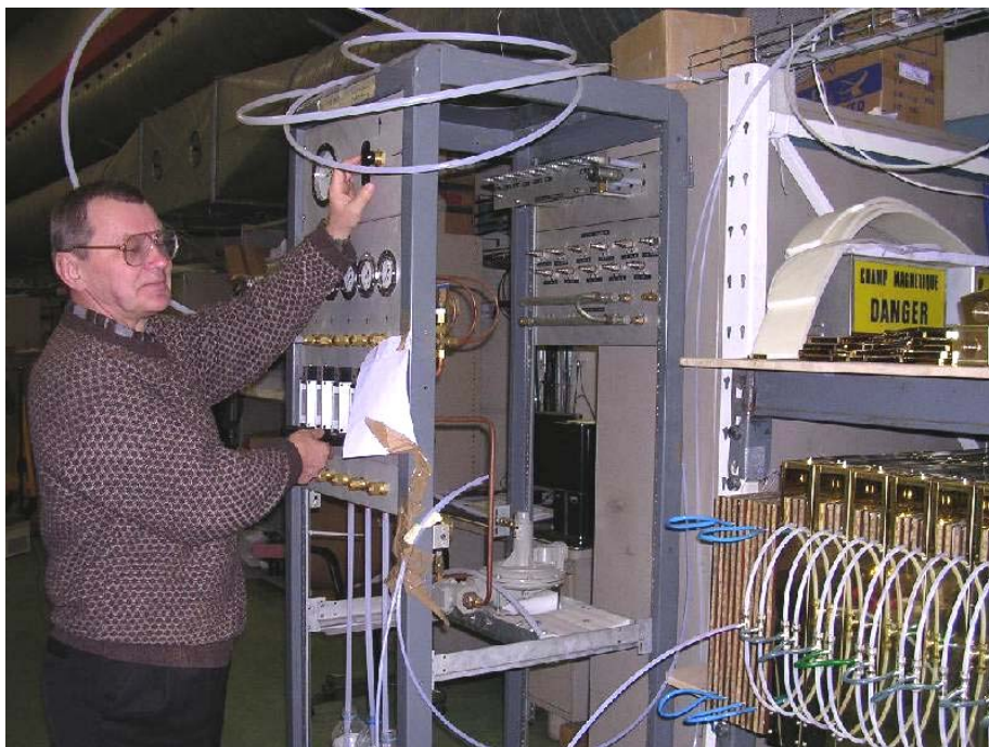
Наполнение камер рабочей газовой смесью
