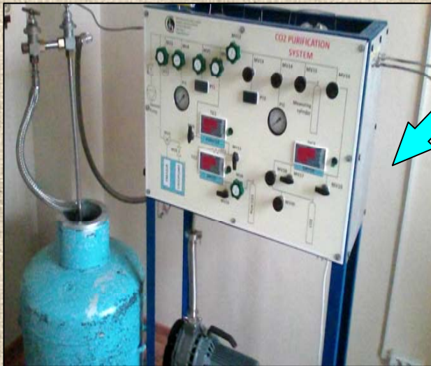
Установка по очистке CO_2
